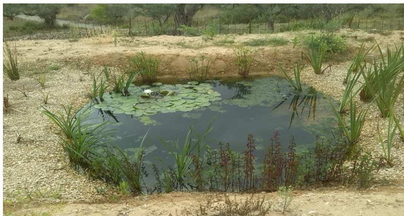
Detall de la bassa de depuració
