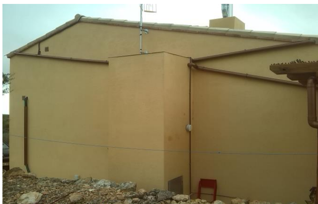
Canalons de recollida de pluvials, aljub, i sobreixidor.
