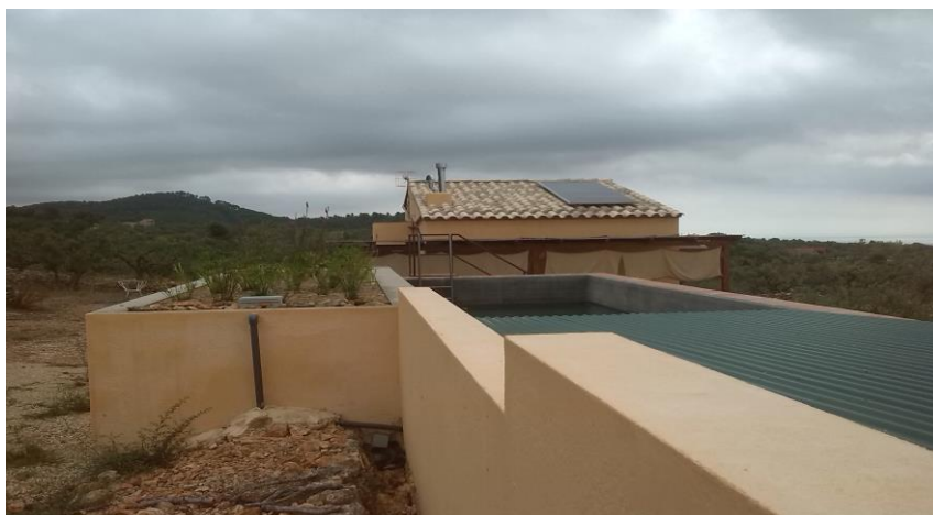
Vista general amb les plaques fotovoltaïques sobre teulada
