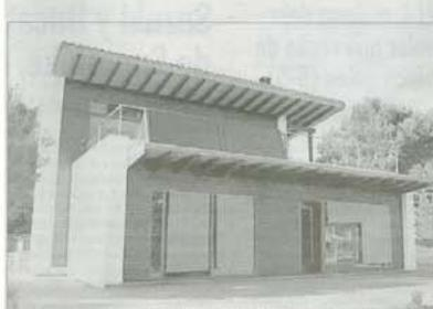
lo que ayuda a su climatización. El edificio valenciano, desarrollado por la empresa Bloco, refleja la importancia que tiene la madera para los ecoarquitectos. Esta forma parte de la estructura, ya que es el material empleado en las viguetas de las cubiertas y en los ventanales. /F
