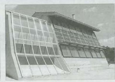
invernadero acristalado y ventanas y balconada en madera. En el inmueble catalán destacan las placas fotovoltaicas para aprovechar la energía solar y el acristalamiento de parte de la fachada. /F
